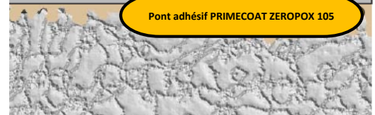
Pose de la chape dans les 15 minutes qui suivent l'application et la pénétration par massage du pont adhésif PRIMECOAT® ZEROPOX 105 dans le support.
