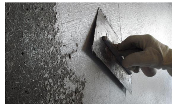
Supports difficiles dans les canalisations
