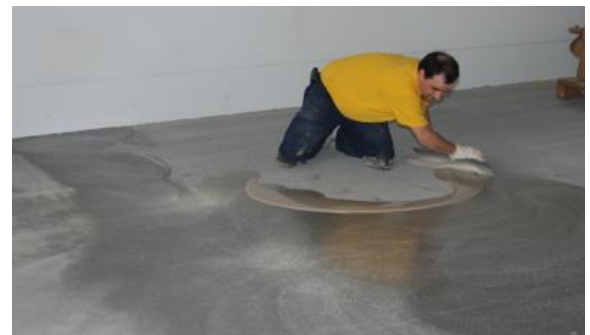
Pose de la couche de fond
