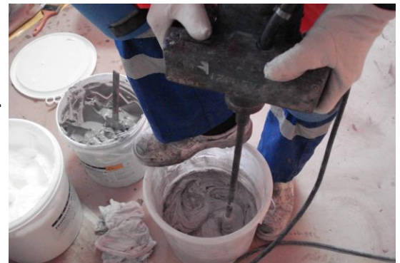
Melange du mastic
