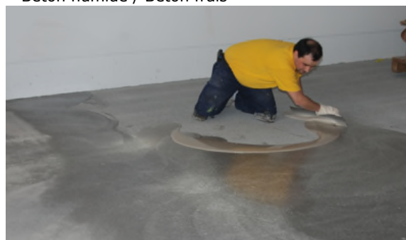
Pose de la couche de fond
