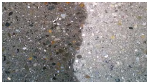
Béton humide / Béton frais
