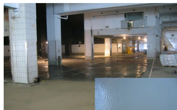
Revêtement résine époxy en support huileux
