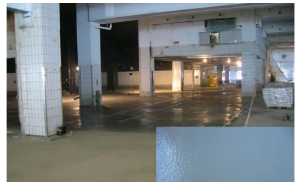
EP-Beschichtung auf dem verölten Untergrund
