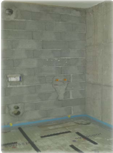
Support mur maçonnerie, poncé, propre. PRIMECOAT 251 application au rouleau.
