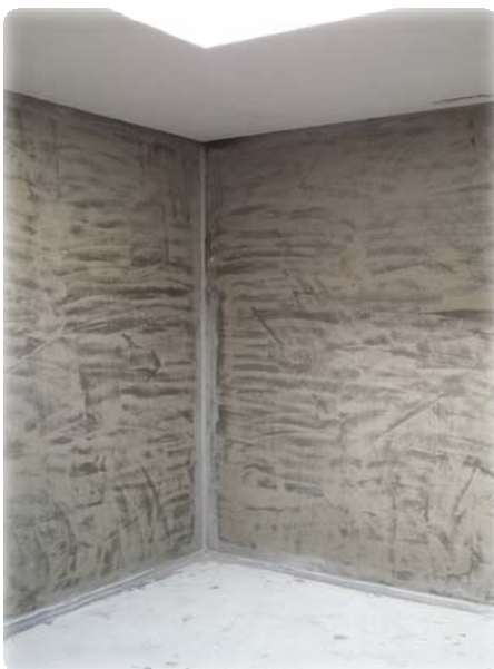
(optionnel) 2. couche PRIMECOAT 255 à spatuler avec ponçage.
