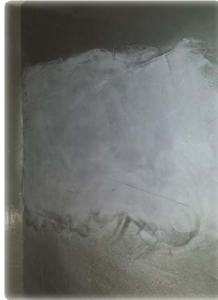
PRIMECOAT 255 lissage à spatuler, avec ponçage.
