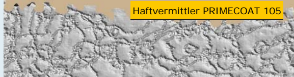
Aufbringen des Estrichs innerhalb von 15 Minuten nach dem Applizieren und einmassieren des Haftvermittlers PRIMECOAT 105
